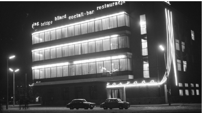
Kaskada nocą — świetlna fasada dawnego szczecińskiego kombinatu gastronomicznego. Źródło fotografii: TVP3 Szczecin.
