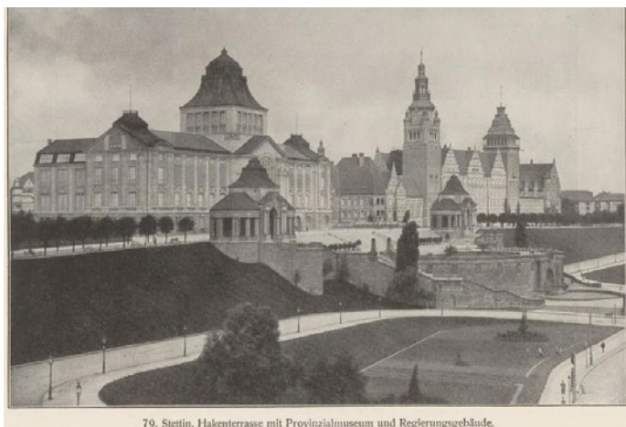
79. Stettin, Hakenterrasse mit Provinzialmuseum und Regierungsgebäude.
