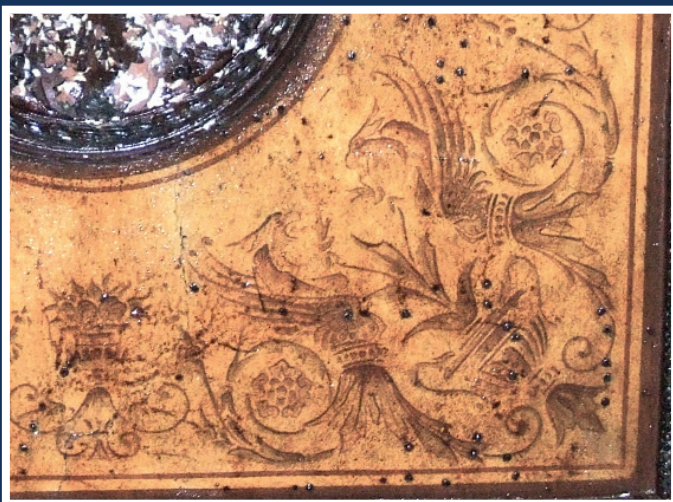
5. ul. Kaszubska 65 - fot. 2005 r. - fragment stropu -detal-skrzydlate grzyf-smoki.
