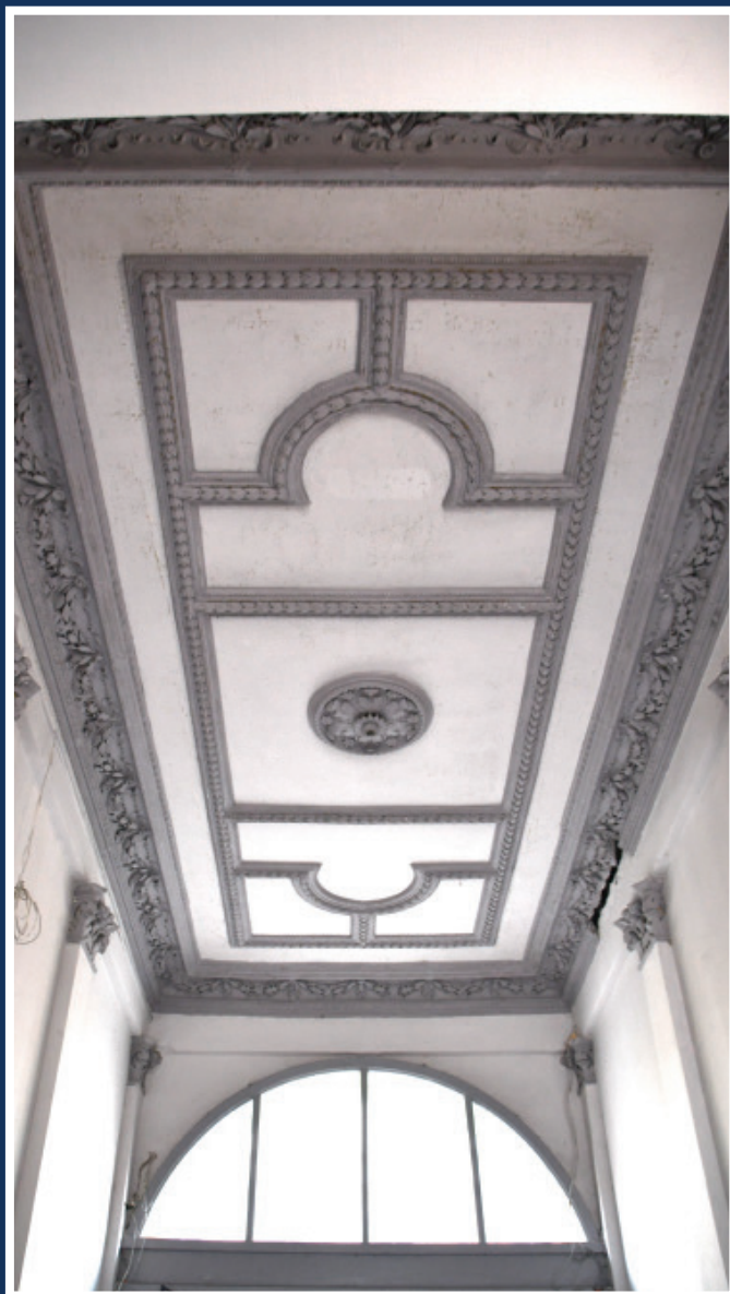
11. ul. Kaszubska 65 - fot. 2025 r. - stan po remoncie.
