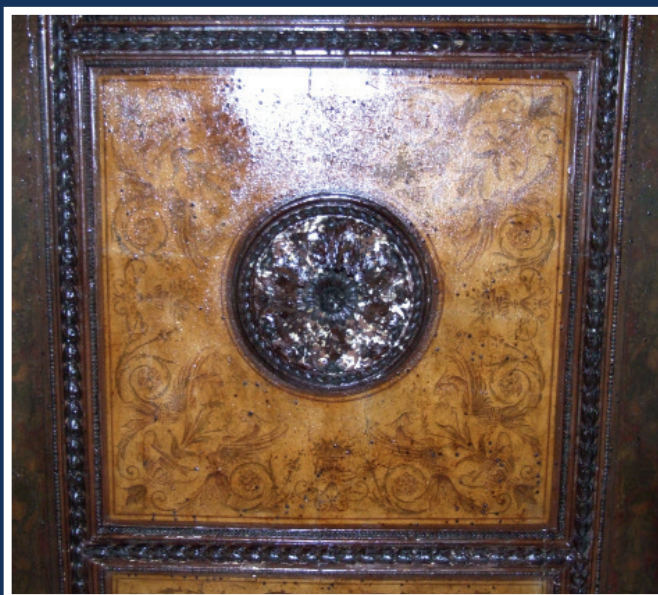
2. ul. Kaszubska 65 - fot. 2005 r. - fragment stropu części środkowej.
